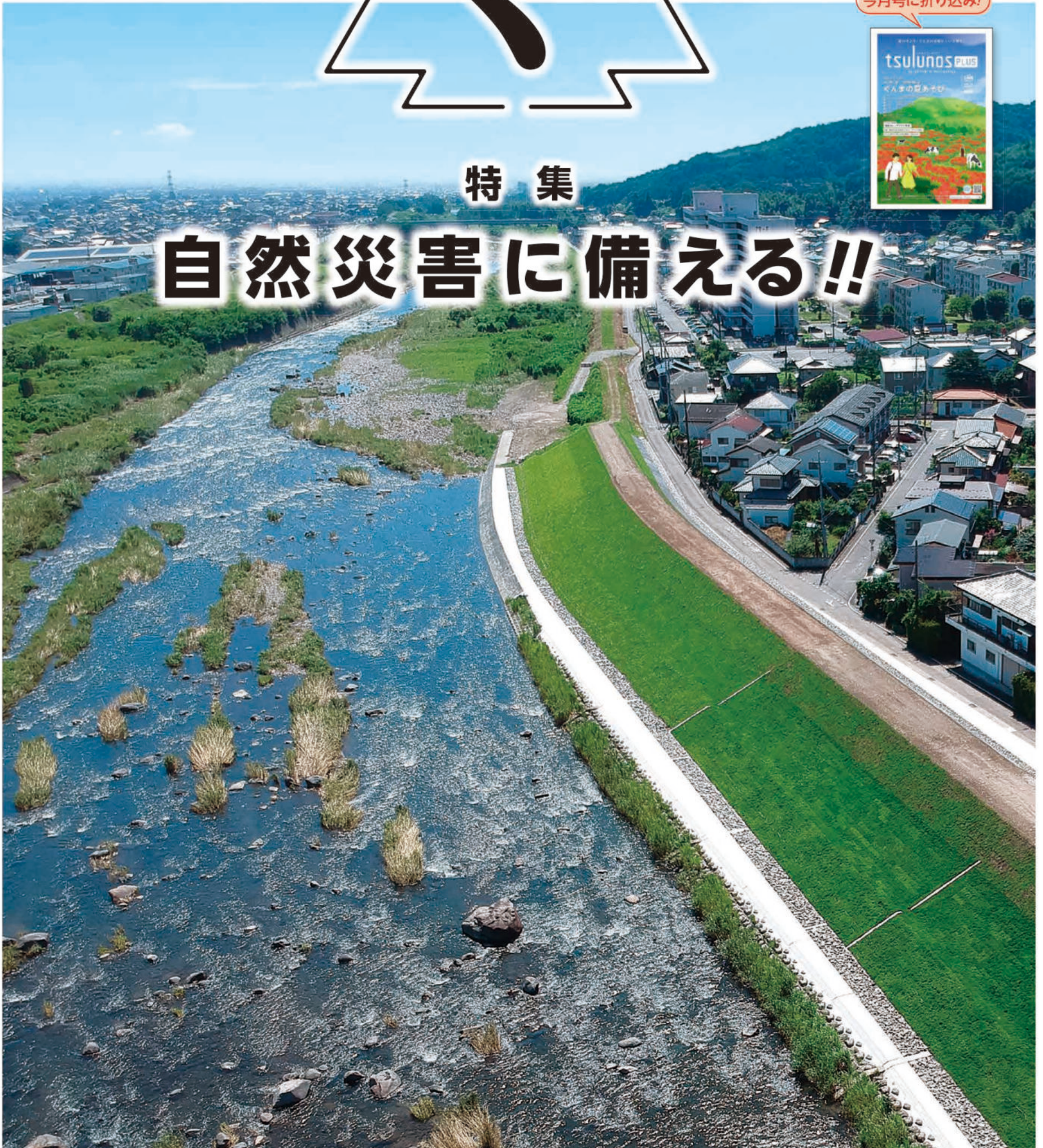
河川改修を行った碓氷川(高崎市)
