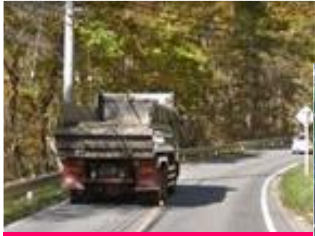
国道144号幅員狭小状況
