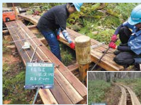
修復が済んだ木道
