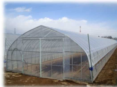
パイプハウス
