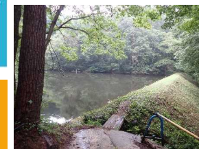
3 和見堤地区 【工事実施前】
