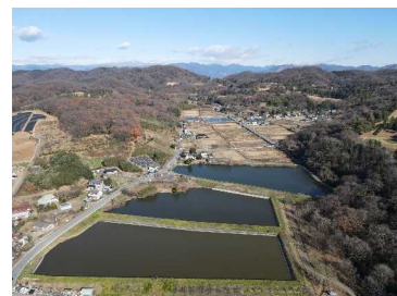
3 西長岡ため池地区 【工事着手前】
