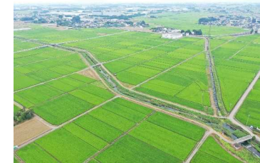
1 野辺地区 【工事着手前】
