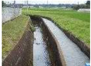
2 神流川用水地区【施設状況】
