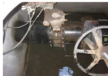
2 利根加用水2期地区 【工事着手前】
