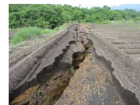
5 松之木平地区 【管破損による農地被害状況】
