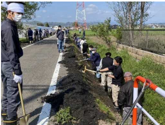
4 高崎市南新波【多面的機能支払交付金を活用した水路の維持管理】
