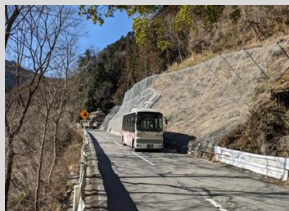
(国) 462号 神流町生利地内 生利工区（R4完成）
