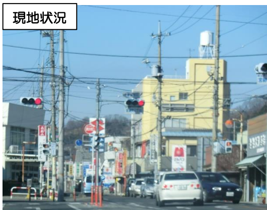
乱立する電柱・電線類
