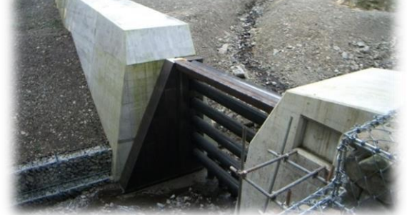
土石流発生前【令和元年9月完成】
