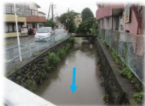
川の断面が小さく、大雨時に水位が上昇し洪水の恐れがあります。
