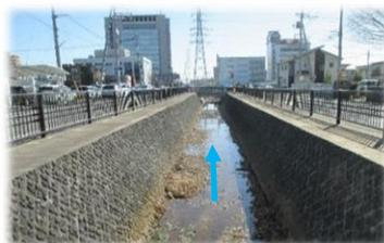
川の断面を広げることで流せる水量を増加させ、水害リスクを減少させます。
