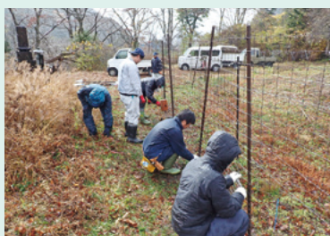
金網設置作業の様子
