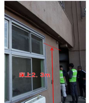
写真 17 床上 2.3m が浸水（大子町庁舎）
