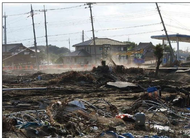
写真 2 全壊した住宅の様子
