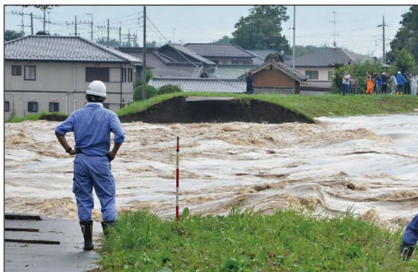
写真 1 堤防が決壊した断面（150m）
