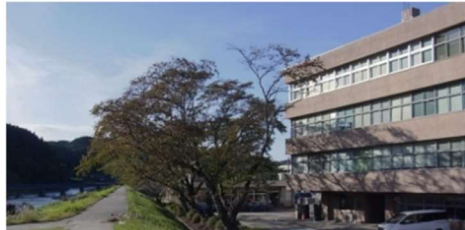
写真 16 大子町庁舎（左側が河川）
