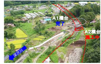
③ 深沢川橋(東吾妻町川戸地内)
