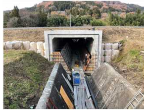
② 30号函渠工(東吾妻町厚田地内)
