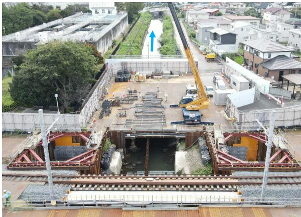
東武鉄道小泉線 小泉町～西小泉間 休泊川橋梁改修工事
