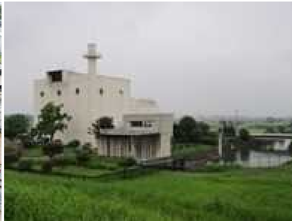
休泊川排水機場
