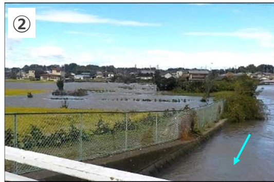
新谷田川放水路沿川の浸水状況
