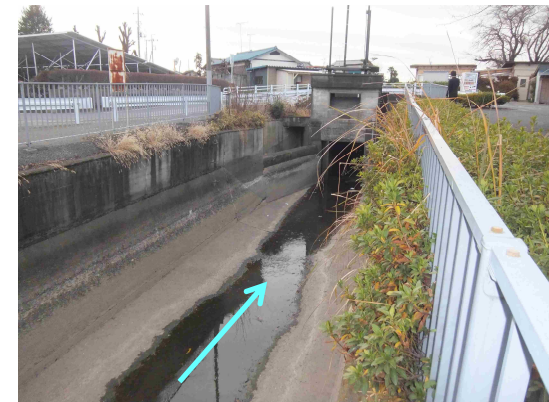
①利根制水門
