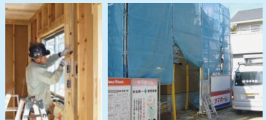
工事現場の様子
