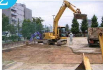
● 校庭表土の削り取り
