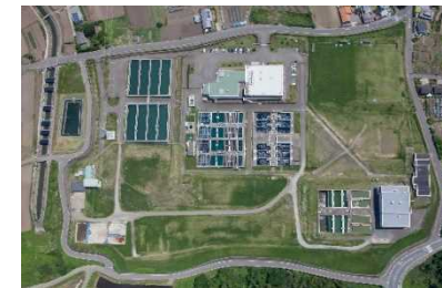
〔県央第二水道浄水場〕
