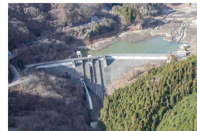
〔霧積発電所建設予定地〕
