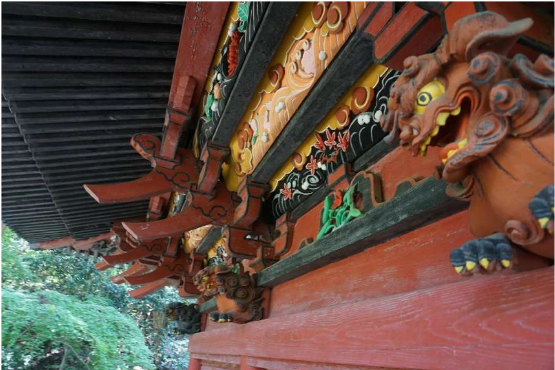
仁王門 上層組物・軒支輪（北から）
