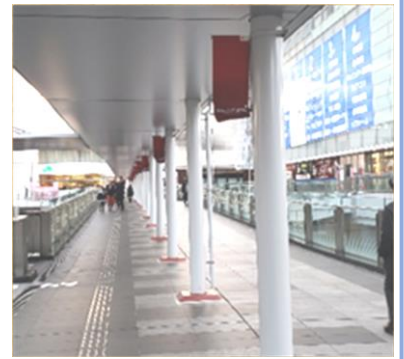
高崎駅東口ペDESTリアンデッキ
