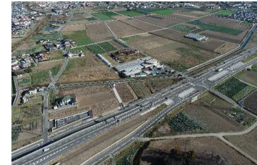
上細井中西部地区 【区画整理工事完了】
