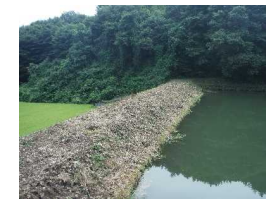
沼田西部1号貯水池 【劣化状況調査】
