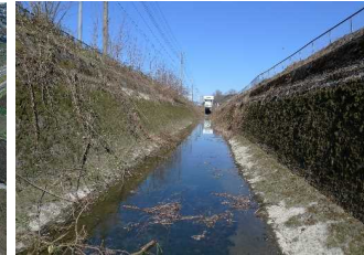
坂東大堰2期地区 【断水時の広桃開渠】
