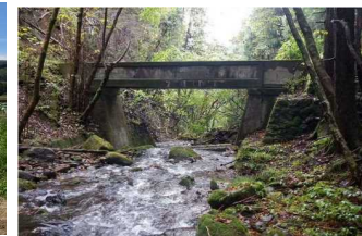
美野原 3 期地区 【改修前の状況】
