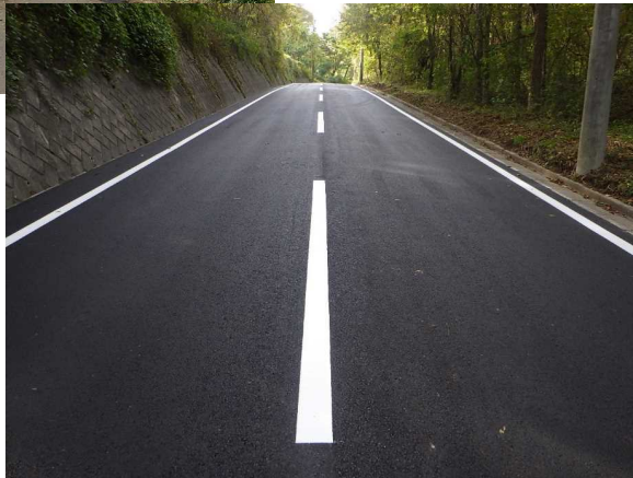
補修した農道 【榛名西麓 2 期地区】
