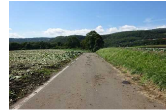
仙之入地区 【完成した農道】
