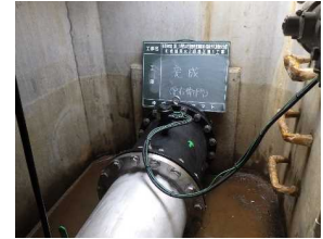
利根加用水2期地区 【対策工事実施】
