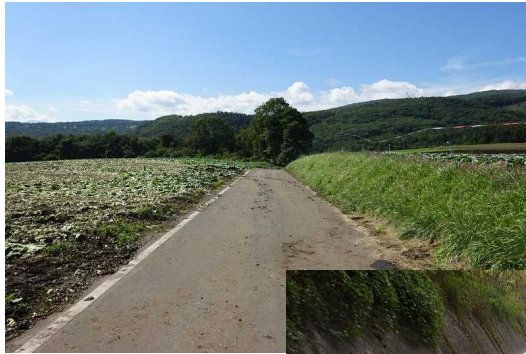
整備をした農道 【仙之入地区】
