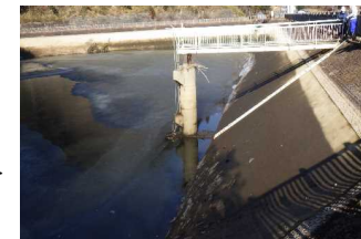
広場貯水池 【劣化状況調査】
