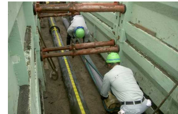
榛名東部地区 【管路工事実施状況】
