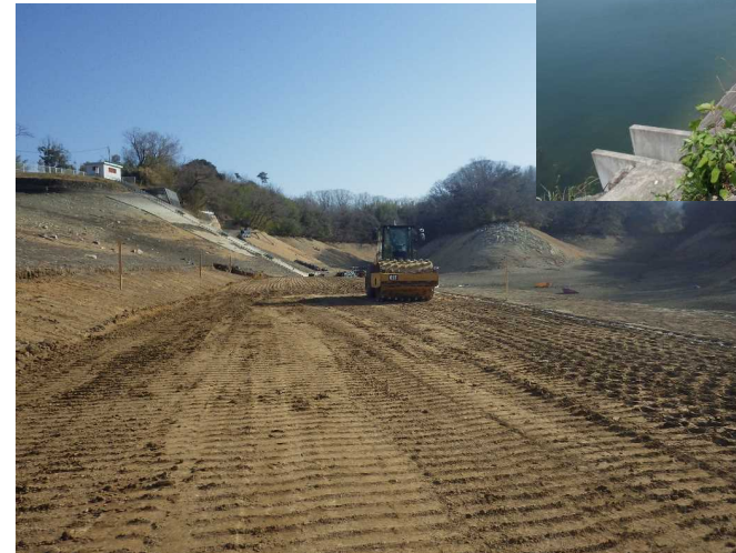
上流側堤体 の盛土状況
