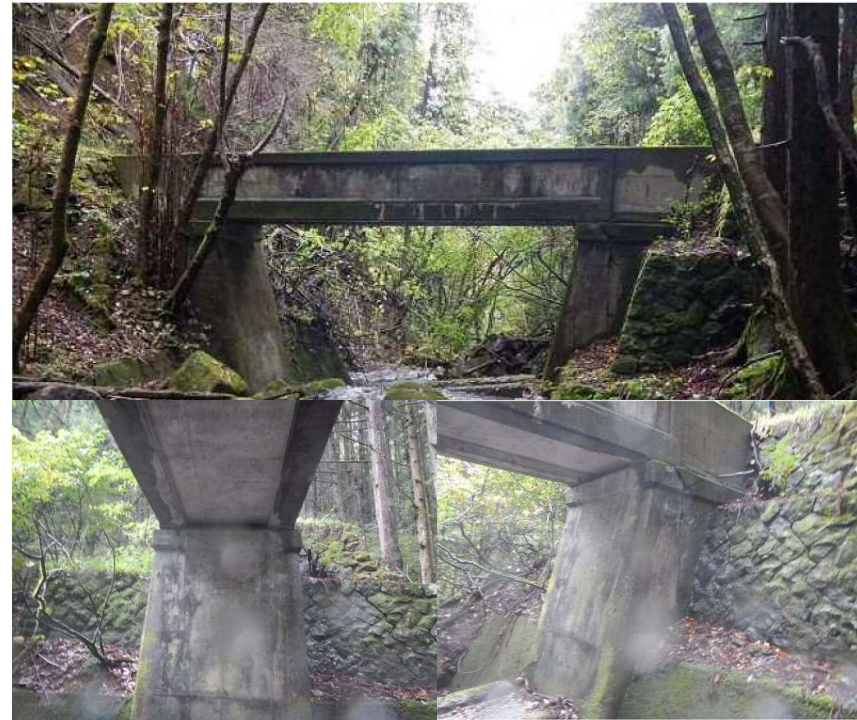
改修前の掛樋
