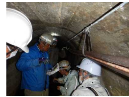
追貝平1期地区 【隧道空洞化調査状況】
