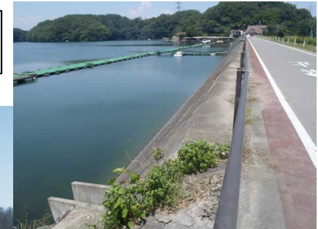
大谷池 (現在の堤体／上流側)
