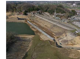
大谷池 【堤体上流側耐震補強 工事着手前】
