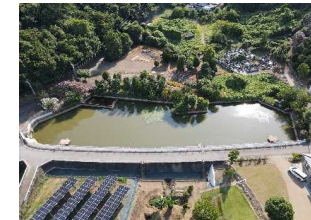
寺ヶ入溜池 【豪雨・地震対策工事完成】
