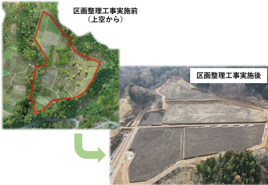
牛の平地区における区画整理工事の実施状況
