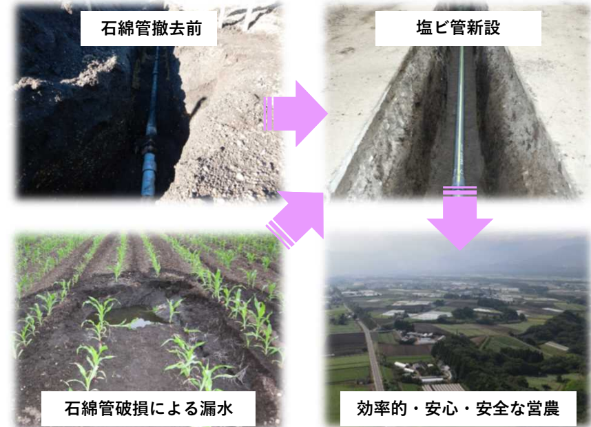
北ろく赤谷地区における石綿セメント管の撤去状況
