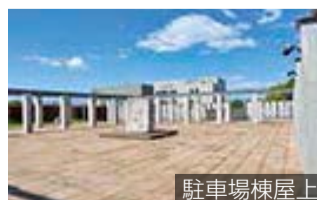
駐車場棟屋上
