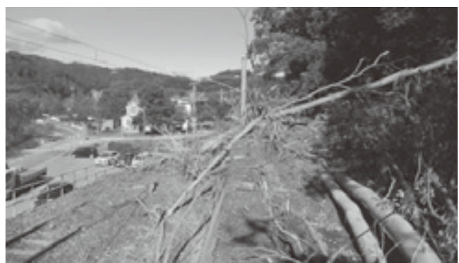
土砂で線路がふさがれたJR吾妻線（嬬恋村芦生田）
