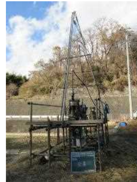
飯島ため池【富岡市】における地震対策調査状況
