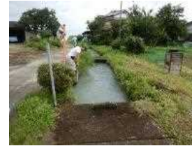
神流川用水地区の通水 試験の状況【藤岡市】
