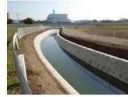
幹線水路を改修した 大正用水 2 期地区 【前橋市、伊勢崎市】
