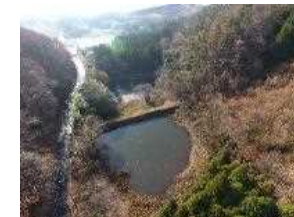
豪雨・地震対策工事に着手した 奥沢下沼地区【桐生市】
