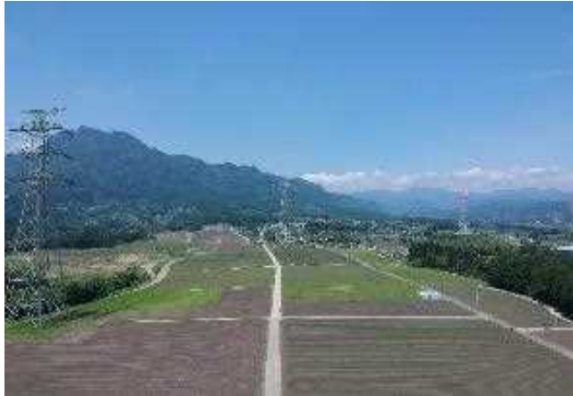
区画拡大された農地状況
