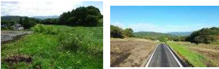
仙之入地区における工事着手前・完成後
