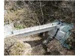
美野原 2 期地区の完成状況 【中之条町】
