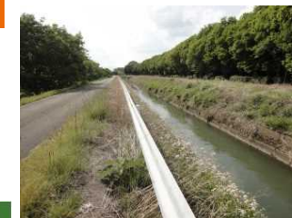
2 大正用水地区【工事着手前】
