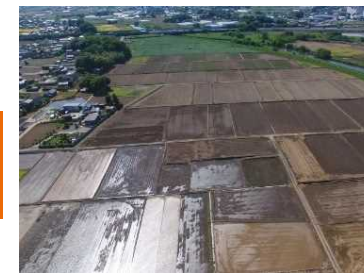
1 下江黒地区【工事着手前】
