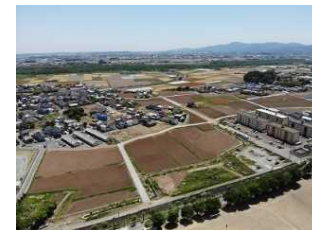
1 笹川沿岸地区【工事完了】
