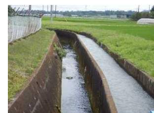
2 神流川用水地区【施設状況】
