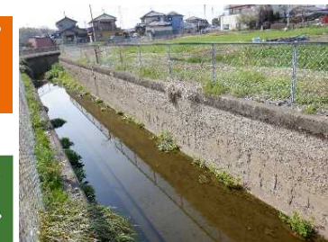
2 藤川用水地区【工事着手前】
