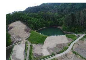
3 池田地区【地震対策工事中】
