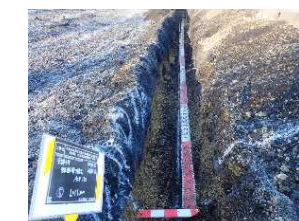
5 赤城原地区【石綿セメント管撤去工事】
