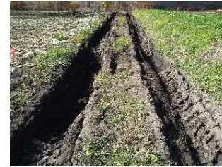
1 仙之入地区【工事着手前】
