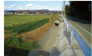
整備された排水路
