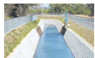
対策後の開水路
