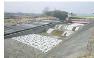
事業実施後の長野堰頭首工
