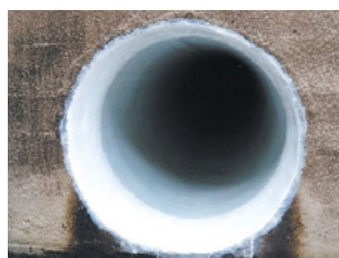
管更生工法により長寿命化が図られた農業水利施設（みどり市：大間々用水地区）
