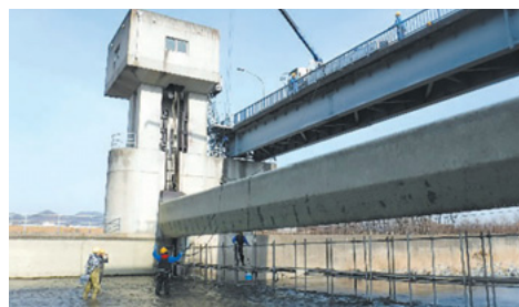
太田頭首工洪水吐ゲートの補修整備（桐生市：渡良瀬川中央地区）
