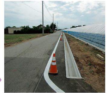
排水路を整備し湛水被害を防止 （太田市：大久保地区）
