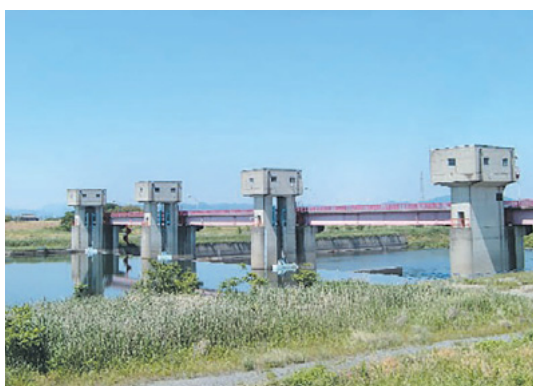
邑楽頭首工 (館林市：渡良瀬川沿岸地区)
