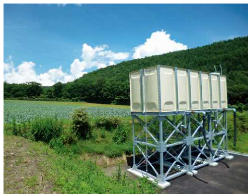
受水槽による防除用水の安定確保 （嬭恋村：干俣地区）
