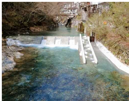
長寿命化が図られた頭首工 （中之条町：美野原地区）
