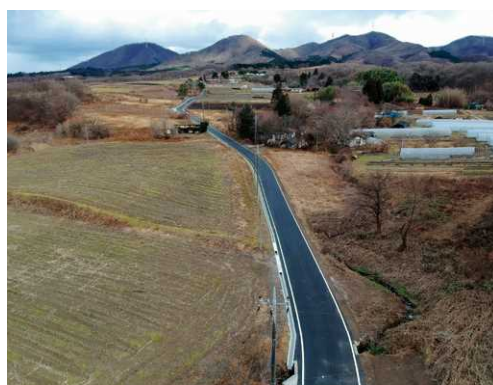
保全対策が行われた農道 （東吾妻町：榛名西麓1期地区）
