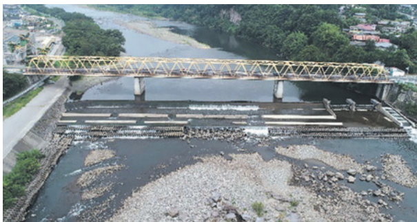
改修前の坂東大堰（前橋市：坂東大堰地区）
