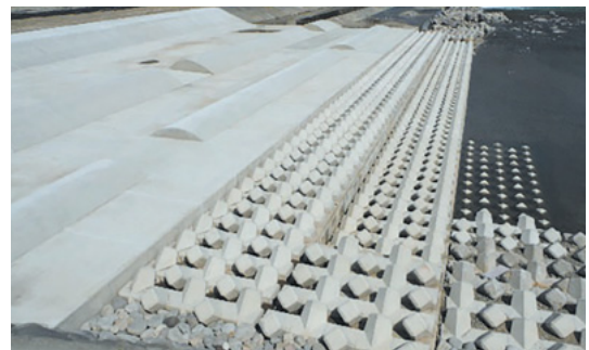
改修後の坂東大堰
