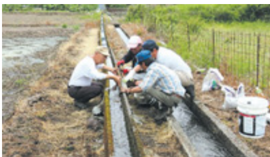
直営施工による水路補修活動（みどり市：東地区）
