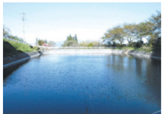
改修した防災重点ため池（渋川市：中野貯水池地区）
