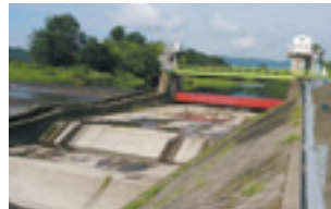
事業実施前の長野堰頭首工
