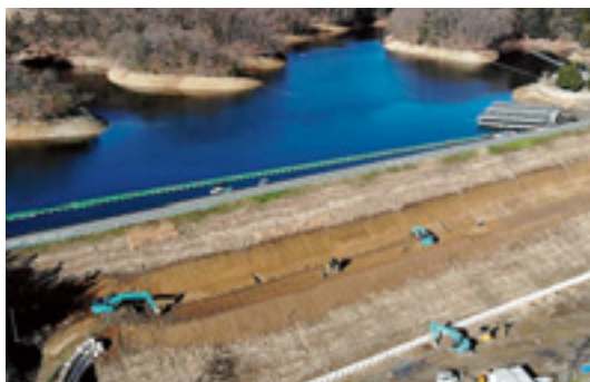
地震対策工事实施中の防災重点ため池（藤岡市：大谷池）
