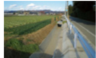
整備された排水路
