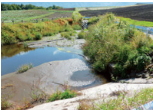
沈砂池の堆積状況（嬬恋村）
