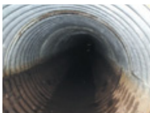
管更生工法により長寿命化が図られた農業水利施設（みどり市：大間々用水地区）
