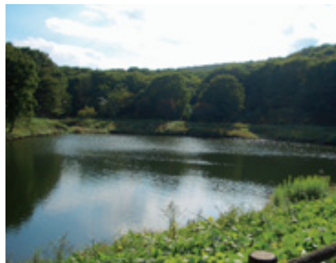
防災重点ため池の状況（高山村：梅沢貯水池）
