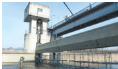
太田頭首工洪水吐ゲートの補修整備（桐生市：渡良瀬川中央地区）
