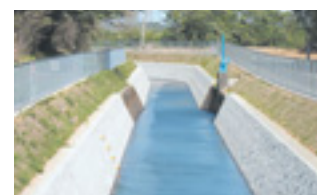
対策後の開水路
