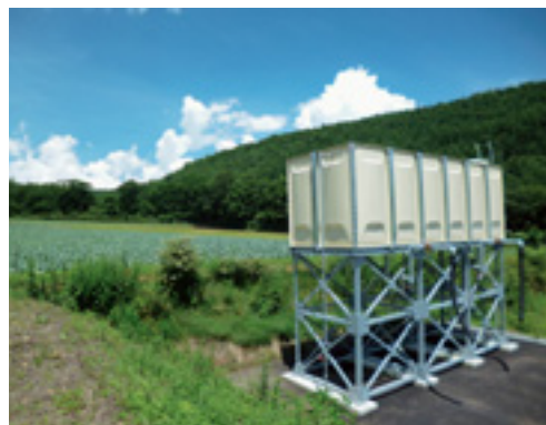
受水槽による防除用水の安定確保 （孺恋村：干俣地区）
