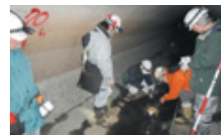
陥没原因の調査
