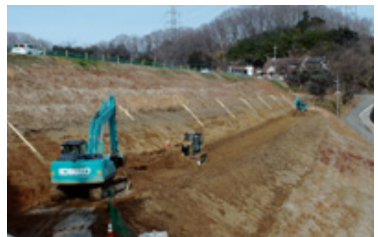
堤体の対策工事状況
