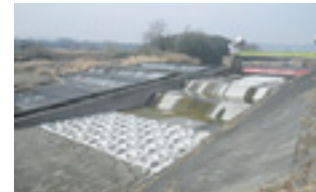
事業実施後の長野堰頭首工
