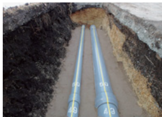
石綿セメント管から塩ビ管への敷設替え状況
