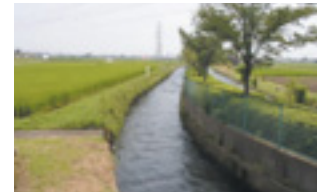
下流の幹線水路
