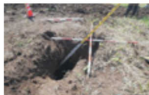
突発的に陥没した農地
