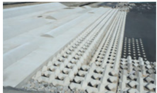
改修後の坂東大堰
