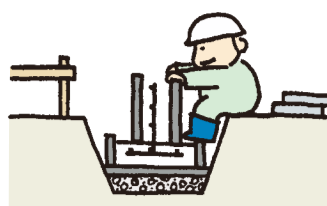
型枠（かたわく）を組み立てます。
