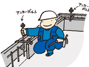
アンカーボルトをセットします。
