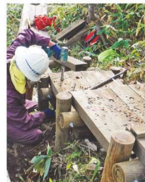
木道工事のようす
