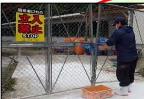
フェンス設置
