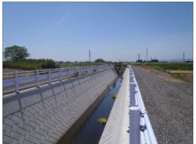
幹線排水路 (整備後)
