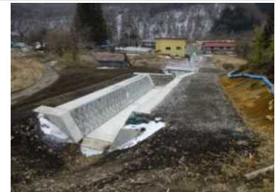
渓流保全工 整備状況
