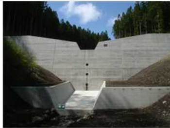
堰堤工 H19完成
