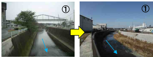
旧カネボウ工場地帯 河道拡幅完成
