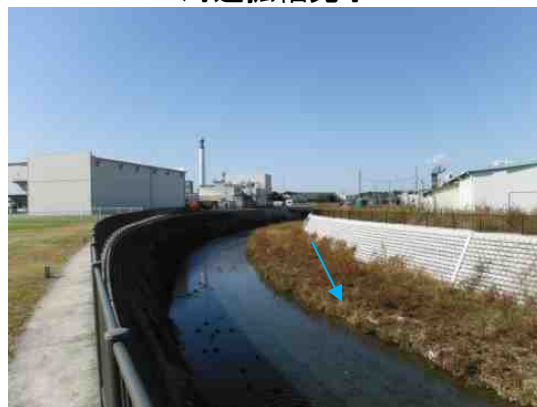
河道拡幅による流下断面の確保
