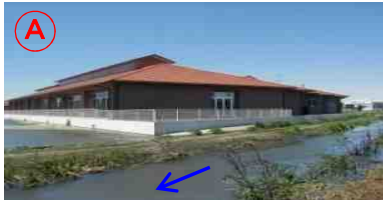
老人ホーム周辺の浸水
