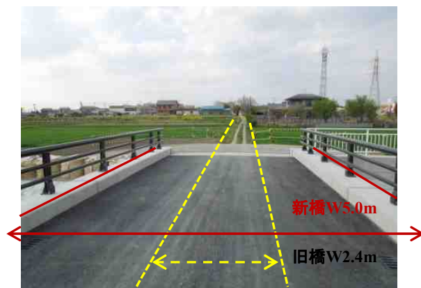
柳島橋(架替後)
