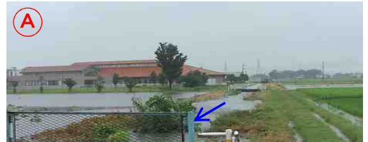
老人ホーム周辺の浸水
