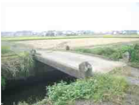
柳島橋(架替前)
