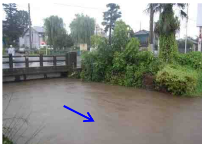
H19. 9洪水(泉大橋)
