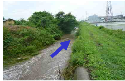
堀の下新橋下流(出水状況) H22.6
