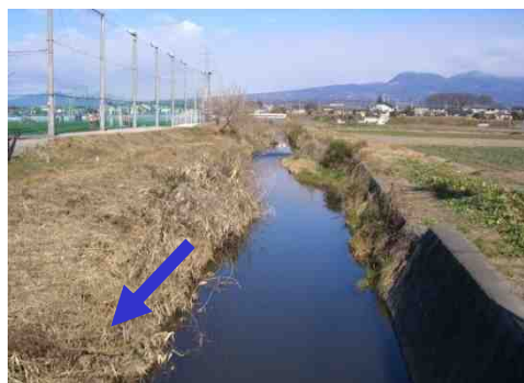
③未整備区間
