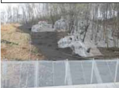
写真：落石防護柵、落石防止網の設置状況
