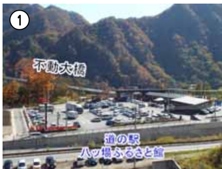
不動大橋(H23.4 開通)
