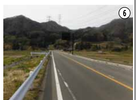
国道~岩島大橋(H20.3 開通)
