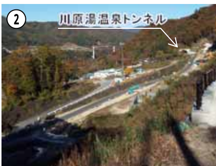
上湯原地区(H27年度完成予定)
