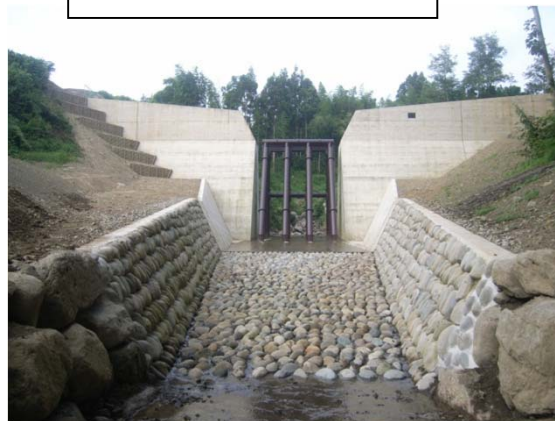
2号堰堤完成写真
