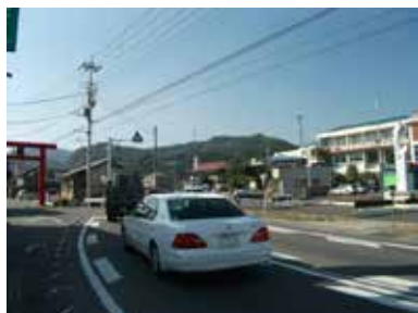
原町地区 交差点 施工状況
