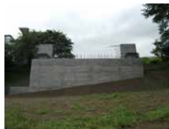
川戸地区 A2橋台 施工状況
