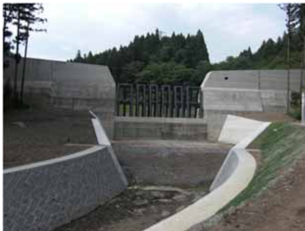
2号堰堤(平成21年度完成)
