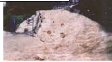
被災状況(H13.8)
