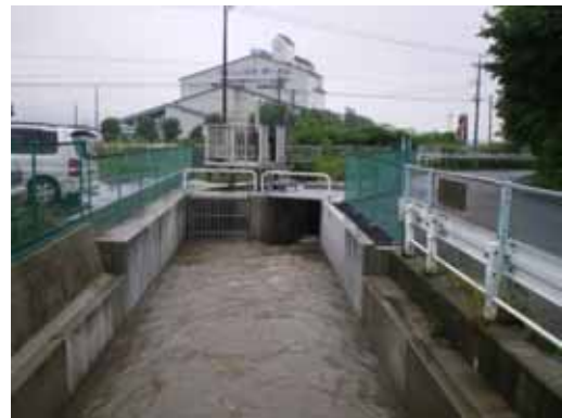
岡登用水路(整備後)
