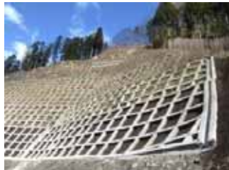
法切工・法枠工 (完了箇所)
