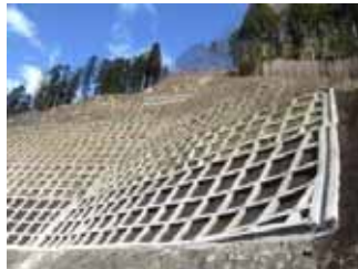
法切工・法枠工 (完了箇所)
