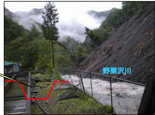
崩壊下部河川状況
