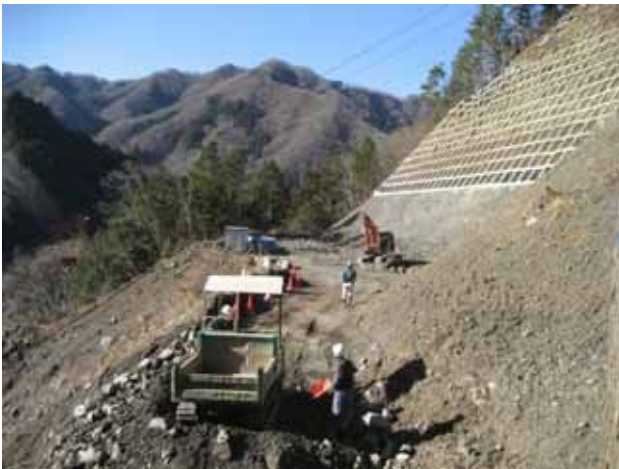
排土作業状況
