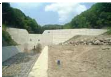
1号堰堤工 (H19完成)
