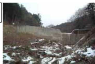
4号堰堤 (H16完成)
