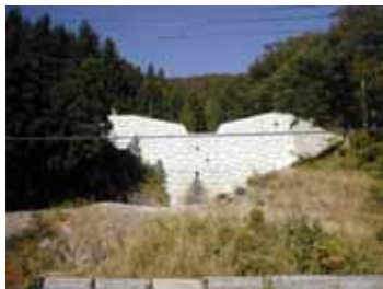
砂防堰堤 (完成)
