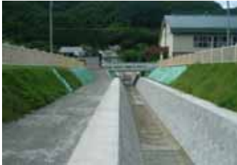
溪流保全工(完成区間)
