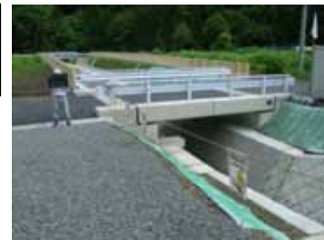
溪流保全工 (完成区間)
