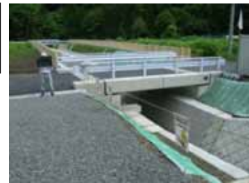
溪流保全工 (完成区間)
