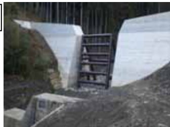
1号堰堤(H20完成)
